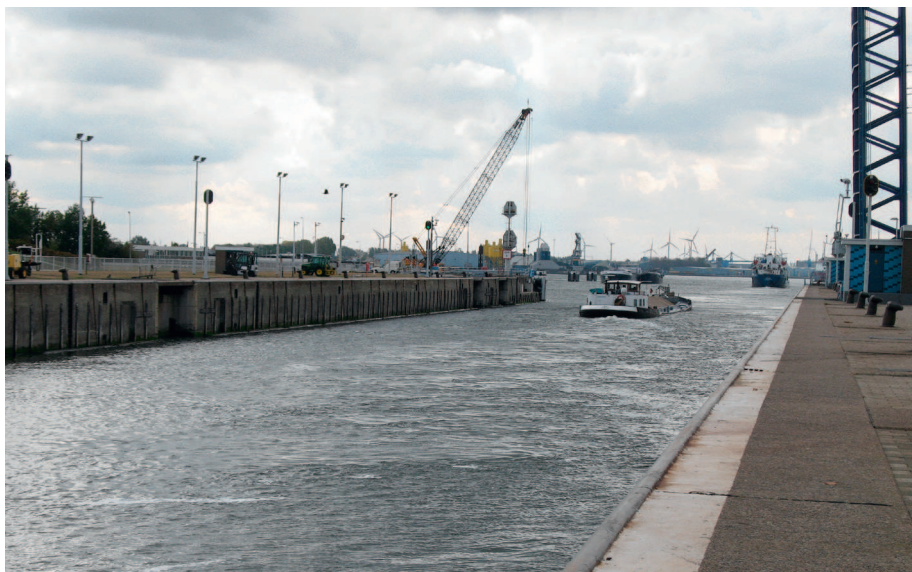
Bij de sluisen in Terneuzen is energiebesparing mogelijk door het zoet-zoutscheidingsysteem slim in te zetten.
