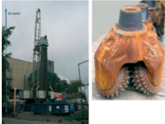
3. Het boren van een onttrekkings- en infiltratiebron neemt enkele maanden in beslag. Rechts een boorbeitel waarmee het bodemmateriaal wordt losgemaakt.
