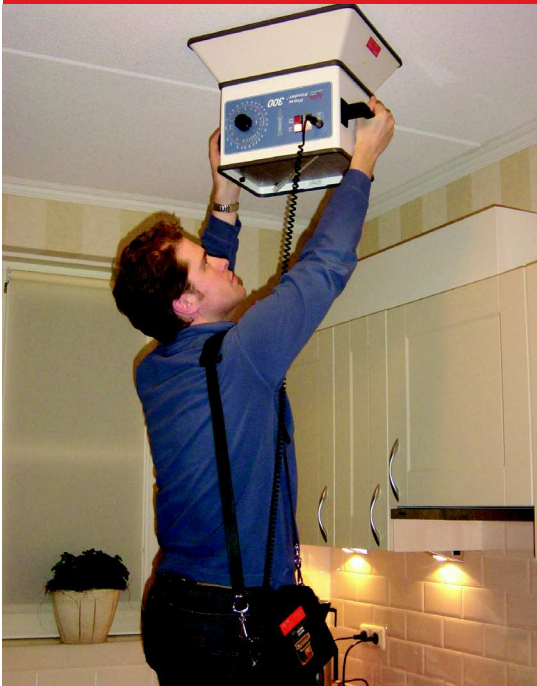
Ventilatiedebietmetingen met een 'flowfinder'.
