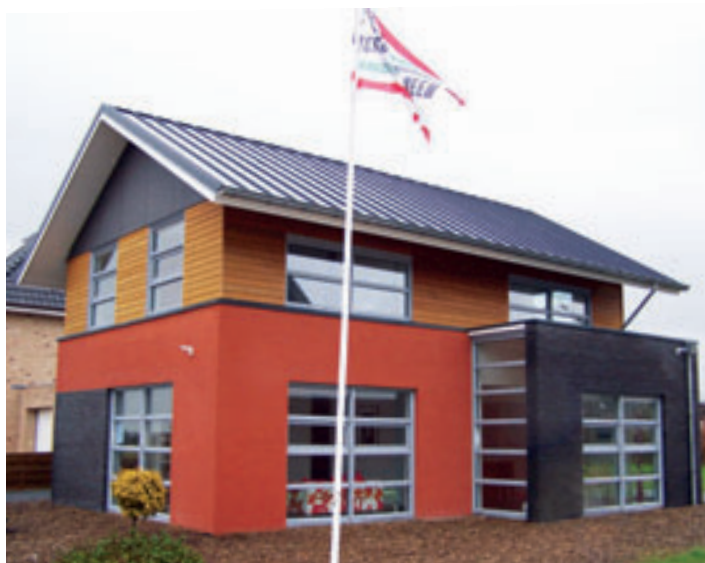
Energieneutraal bouwen op een traditionele manier.
