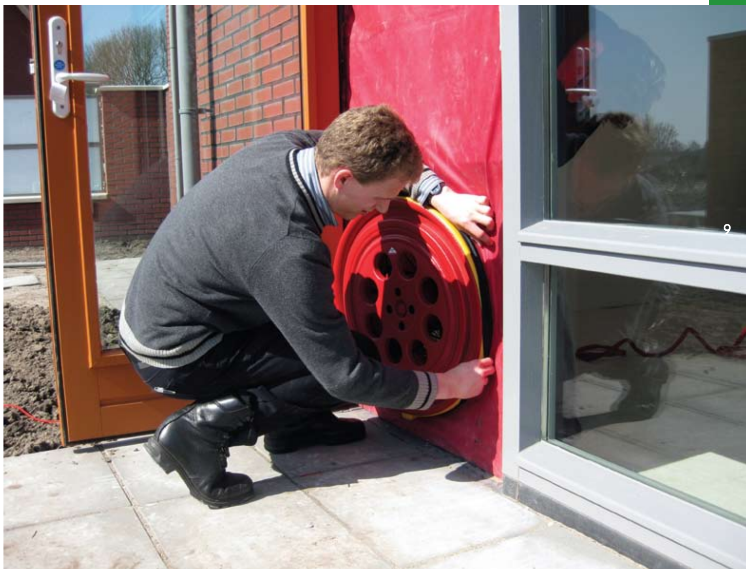
Uitvoering van de blowerdoortest.
