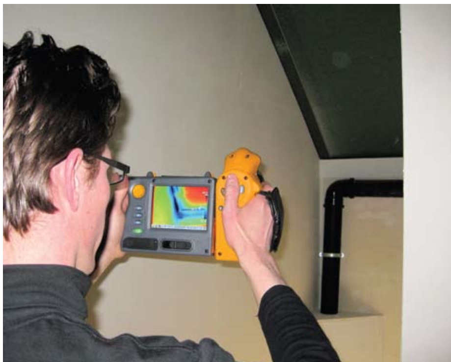
Opname met infraroodcamera van aansluiting dak- en gevelconstructie.
