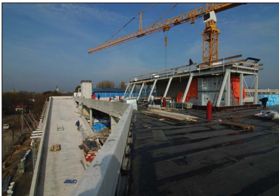
Als eerste werd een volledig verkleefd bitumen membraan aangebracht als dampremmende laag. Foto: Royal Haskoning
