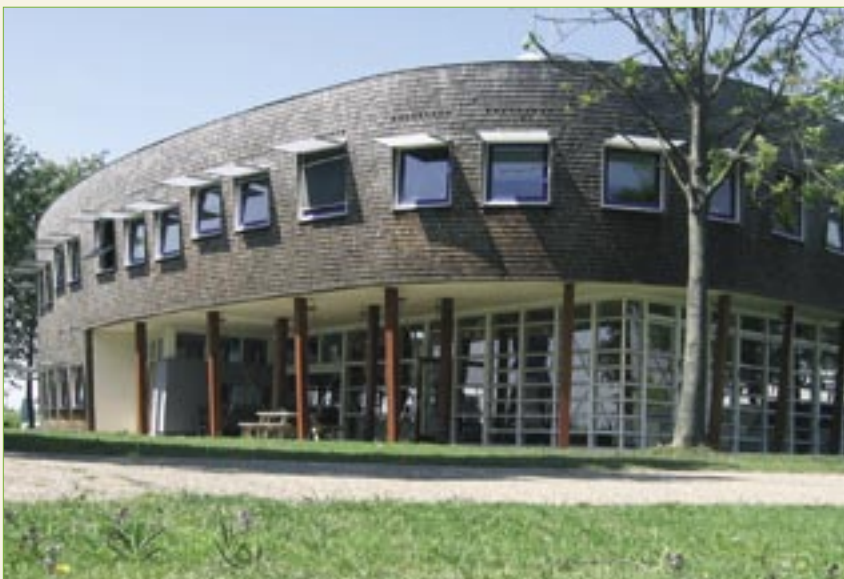
Rijkswaterstaat Terneuzen; één van de tien onderzochte gebouwen.
