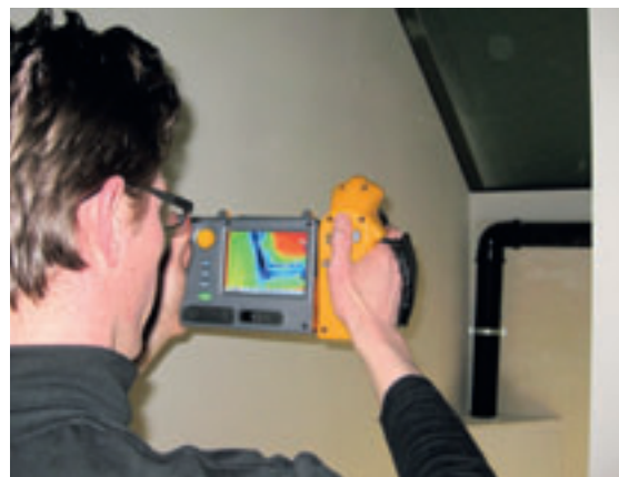
Opname met infraroodcamera van aansluiting dak- en gevelconstructie.
