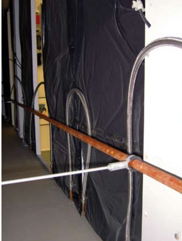
■ Aansluitingen klimaatpanelen (links) en slib vrijgekomen na het spoelen van de installatie (rechts).
