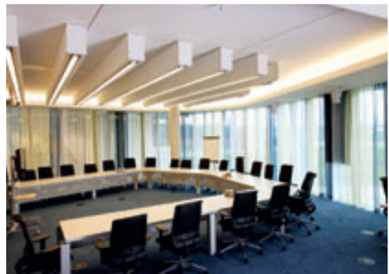
3. De verlichting van de vergaderzaal van het waterschapskantoor in Ridderkerk (tevens akoestische voorziening).
