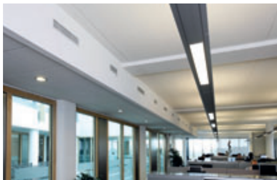
6. De verlichting met pendelarmaturen in het kantoor van Stabiplan in Bodegraven.
