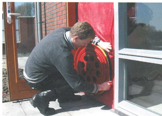
Met behulp van een blowerdeur wordt de woning, nadat ventilatiekanalen en sifons zijn gedicht, in onder- of overdruk gebracht. Vervolgens kunnen warmtelekken worden gemeten.
