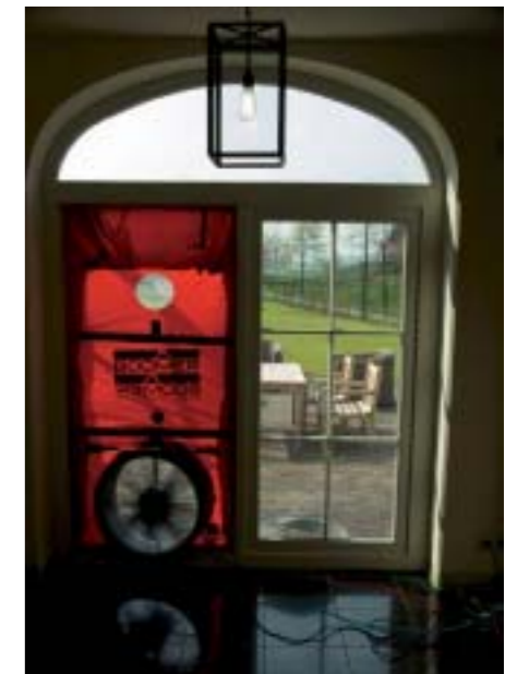
Een ventilator brengt de woning in onder- of bovendruk
