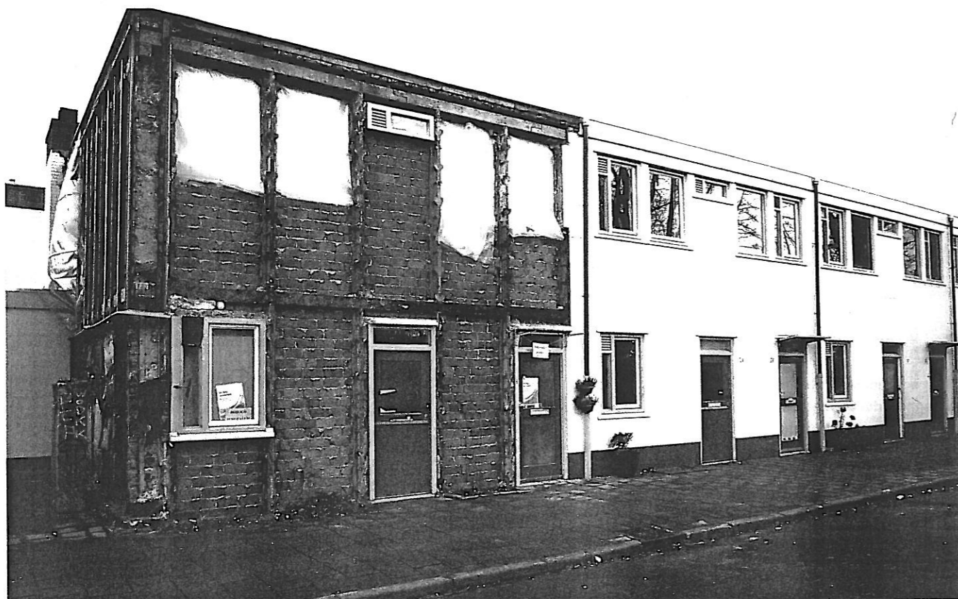
De naoorlogse wijk Jeruzalem in Amsterdam wordt voor de helft gerenoveerd en voor de andere helft gesloopt en opnieuw gebouwd. Stadsdeel Oost-Watergraafmeer heeft plannen om de wijk CO 2 -neutraal te maken. (Foto Christiaan Krop)
