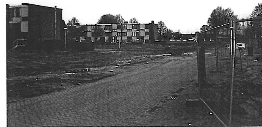
Onlangs heeft woningverhuurder SWZ besloten ook de resterende ‘trapjeswoningen’ in Zwolle tegen de vlakte te gooien, renovatie zou de levensduur niet genoeg verlengen. Foto's MMVW
