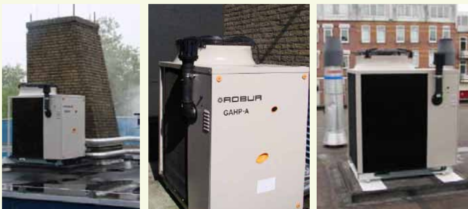
De gasabsorptiewarmtepompen bij de drie zwembaden van Sportfondsen Nederland, van links naar rechts: Didam, Roelofarendsveen en Rotterdam
