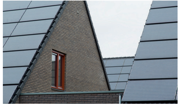
De zonnepanelen op de daken van de woningen (gemiddeld 35 vierkante meter per woning) zijn gekoppeld aan het eigen gebruik.
