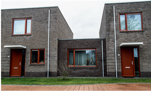
Van Loon: "Dit was voor ons het eerste project, waarbij we het stokje zo ver hebben gestoken: op energieneutraal."
