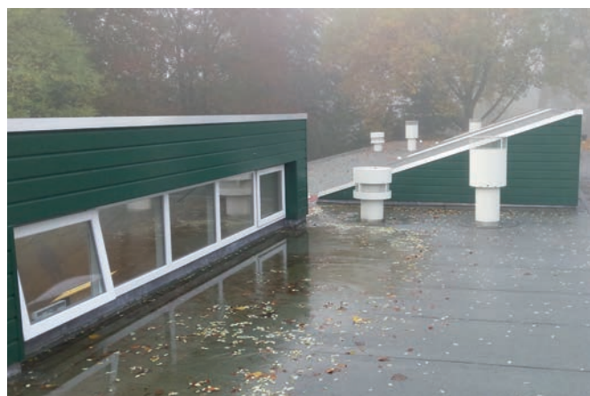
Het dak is 6 cm hoger geworden; dit is opgelost in de aansluitdetails en dakrand.
