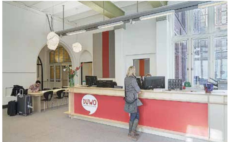
Via slimme en architectonisch fraaie technische stroken zijn verlichting, elektra-doorvoer en akoestiek opgelost.
