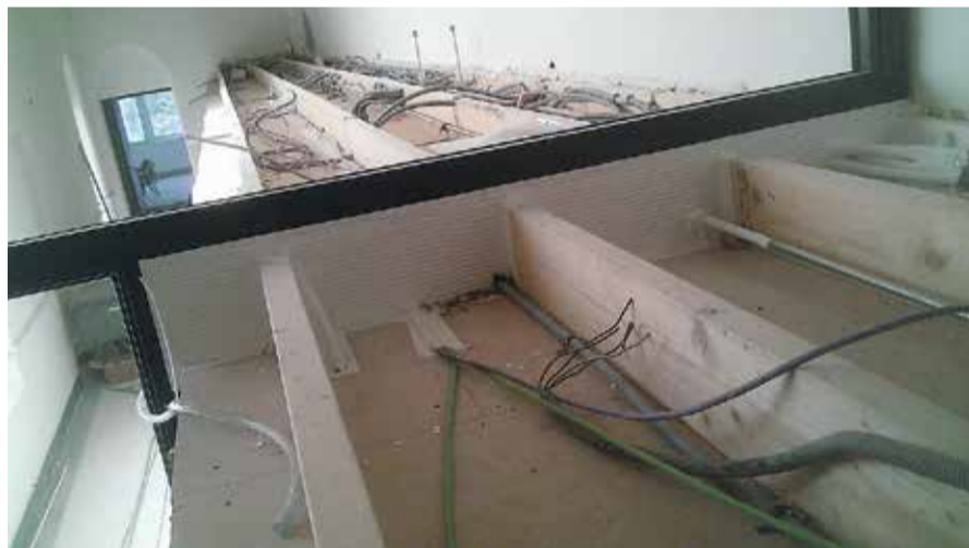
Boven het plafond van de natte cel en woningen was een onopvallende plek voor kabels en leidingen.
