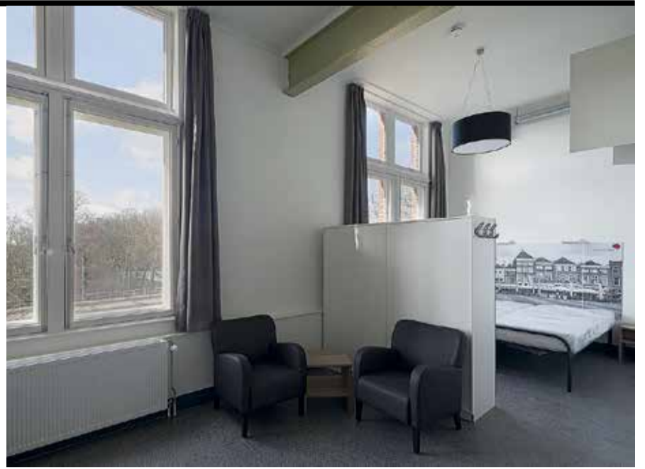
In de woningen is alleen de lage temperatuur radiator, de toevoerbuus voor luchtbehandeling en een afvoerrooster zichtbaar.
