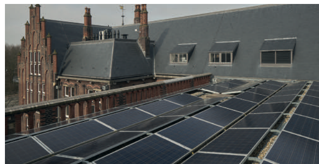
De 100 pv-panelen op het dak van het gebouw zorgen er voor dat de studentenwoningen een energielabel B hebben. Foto: Gerard van Beek
