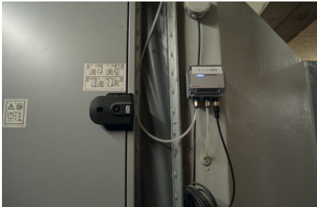
Bij BaOpt/Climotion speelt luchtdruk een grote rol. Die moet daarom goed gemeten worden. Onderin de regelkast zijn de luchtdrukslangetjes te zien. Foto's: Tijdo van der Zee
